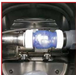
Rückschlagventil RSK und Schmutzwasserpumpe
