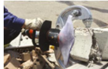
Eine perfekte Kombination: Beton mit dem CC 23 wegbrechen und Betoneisen mit dem Minischneidergerät CU 4007 oder SMC 5006 schneiden.
