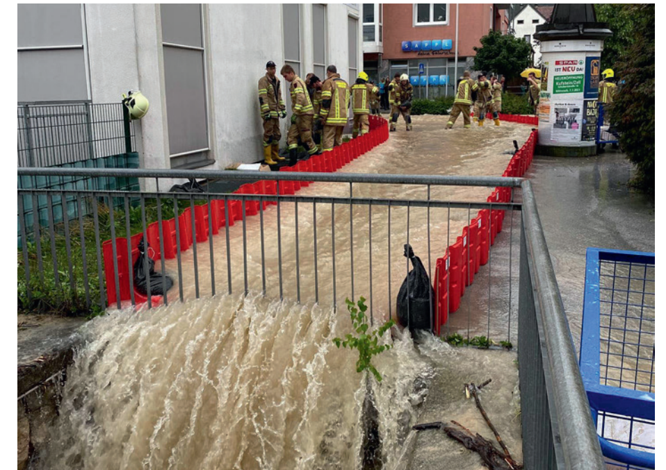
Die mobilen Boxwall-Elemente von NOAQ können schnell und unkompliziert zur Ableitung von Wassermassen eingesetzt werden.
